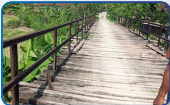
Pekerjaan Jembatan Jiporapah Jombang Bridge Construction at Jiporapah Jombang
