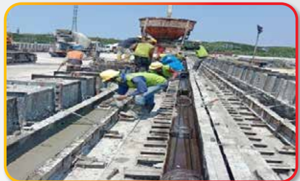
Project Pekerjaan Pembangunan On/Off Ramp Papanggo Utara On/Off Ramp Papanggo Utara Construction Project
